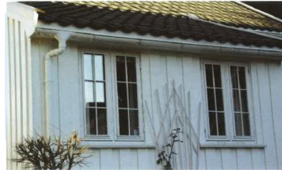
Foto viser lite heldig løsning med isolerglass og falske sprosser med feil sprosseindeing.
