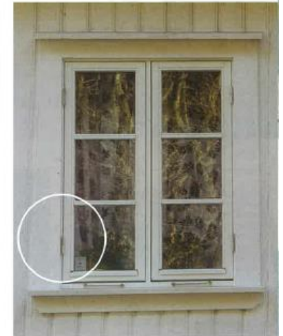
Foto viser et hus med originalvindu til venstre og utskiftet vindu til høyre på samme fasade. Utskiftet vindu er i isolerglass med feil dimensjon og detaljering på sprosser.
