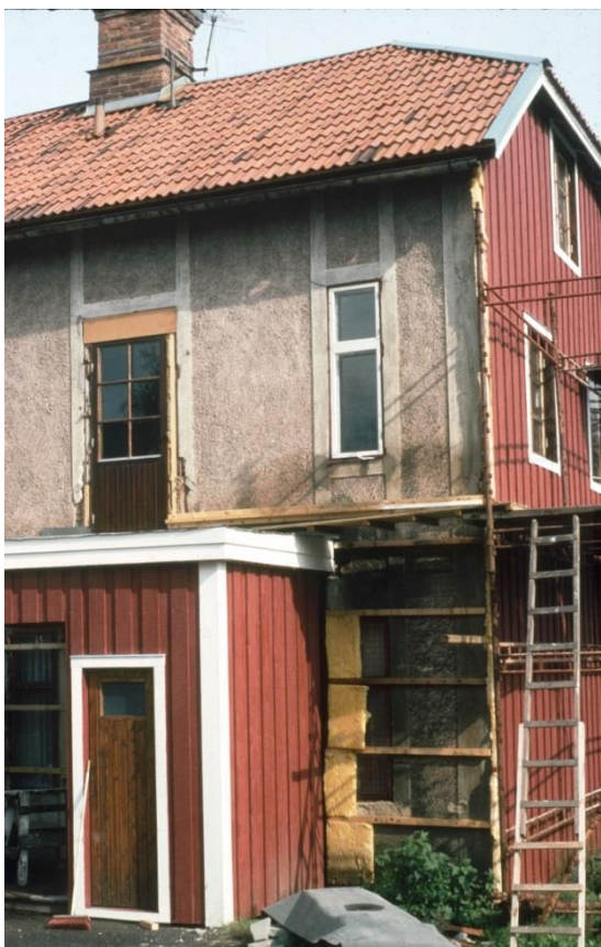
Figur 14 Tilläggsisolering i Hudiksvall 1980.
